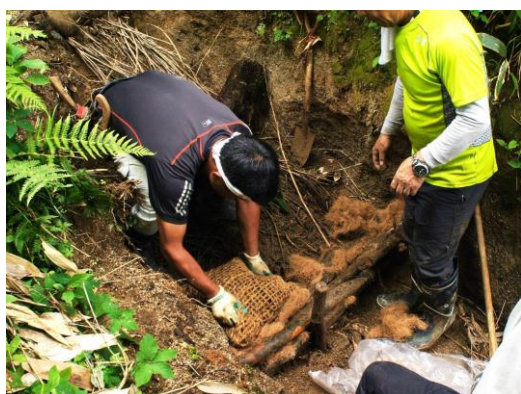
【ヤシ繊維、土のう、樹枝等による土留作業の様子】
