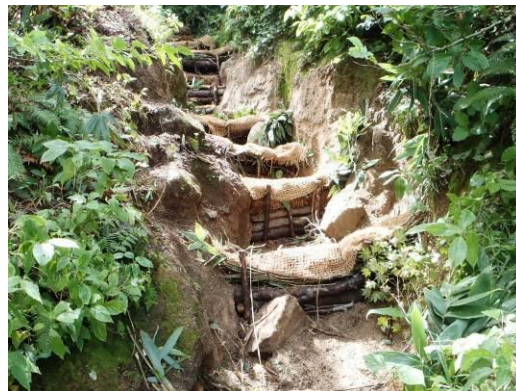
【左同箇所の作業後（樹枝、ヤシ製ネット等による土留工）】
