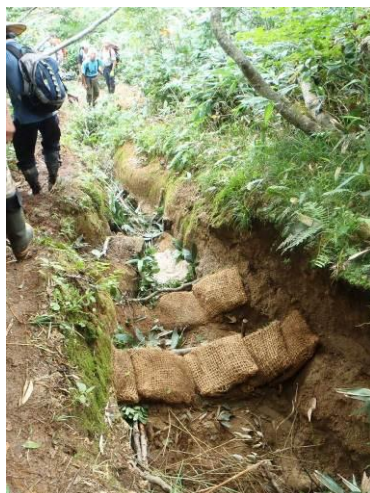
【←土のう、ササ束等による土留工】
