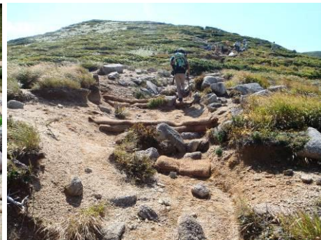
【ヤシ製ネット・土のうによる土留工】
