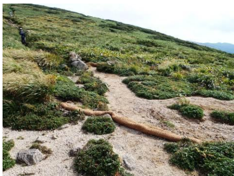
【土留による排水工】
