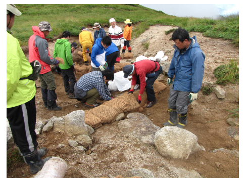
【ダムを造っているところ】
