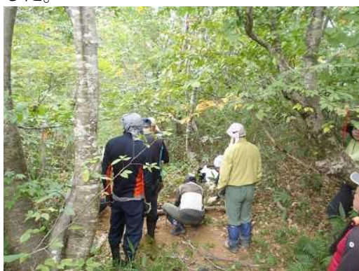
【倒木を利用して、排水対策作業中】
