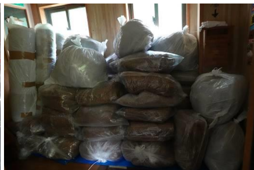
日暮沢小屋に置いた荷揚げ前の資材
