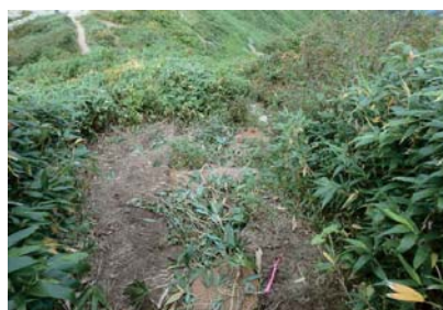
ササとヤシ土嚢で処理・閉鎖
